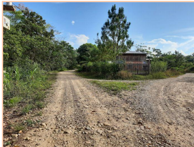
Foto N° 48: Camino vecinal R2503005
